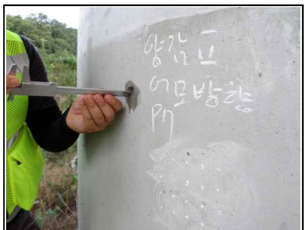
탄산화 시험 깊이 측정
